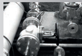
Härteste Testbedingungen in der Versuchsanlage des Fraunhofer-Institutes.
